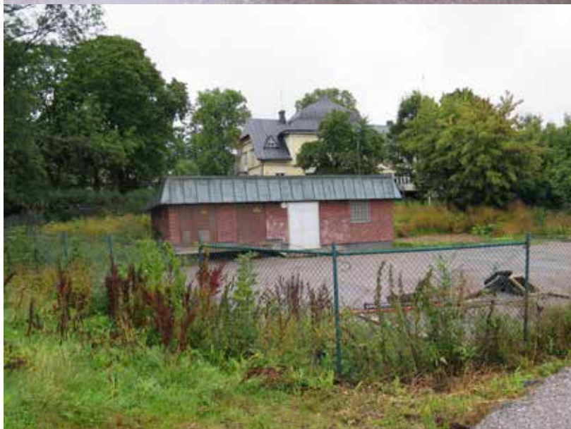
Fig. 23. Övre bilden. Byggnad 8. Byggnaden fotograferad från sydväst. LP_2014_00166.
