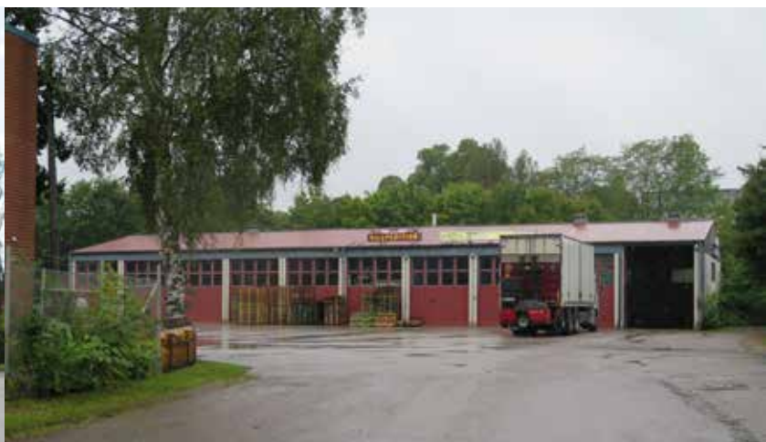
Fig. 30. Byggnad 13. Byggnaden fotograferad från öster. LP_2014_00173.
