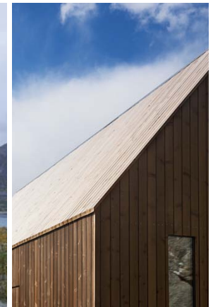
Sömlös övergång mellan tak och fasad
