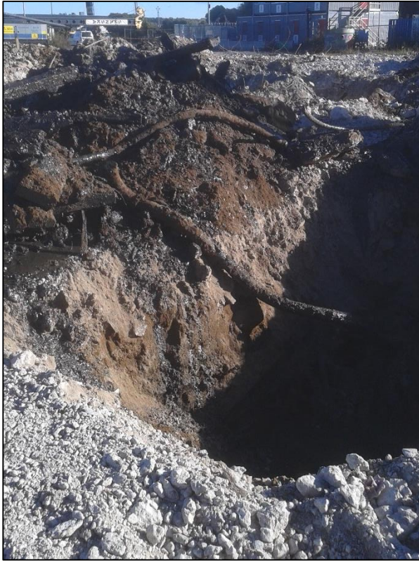
Fyllning med stora mängder skrotinnehåll.
