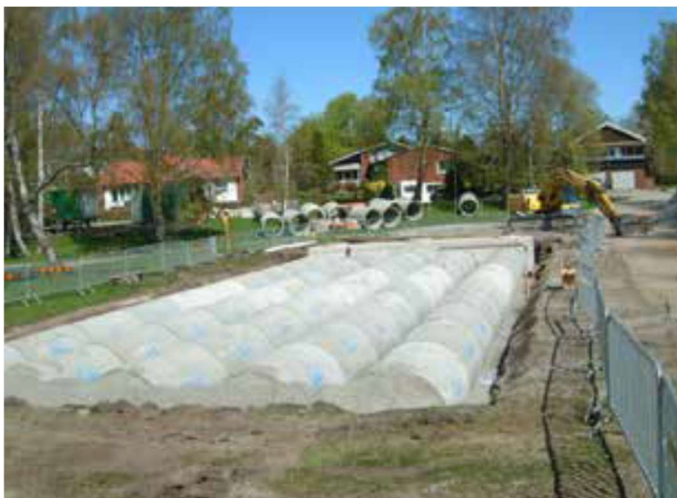
Figur 8. Exempel på underjordiskt rörmagasin i betong.
