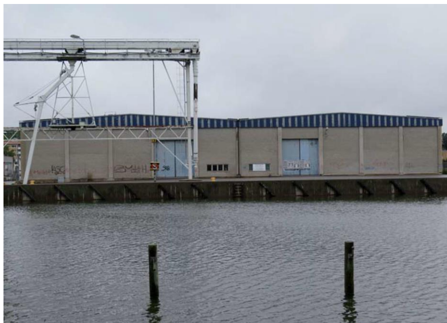
Figur 9. Spannmålsmagasinet fotograferat från Societetsparken innan rivning (foto: Stockholms läns Museum, Rapport 2014.23, Kulturhistorisk dokumentation av Norrtälje hamn, Tälje 3:1 med flera).
