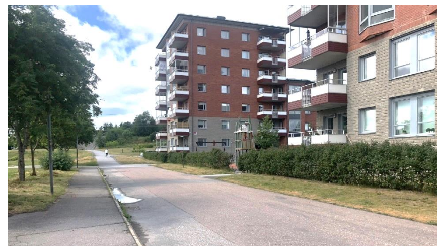
Foto AFRY. Gång- och cykelväg på Vigelsjövägen norr om nuvarande skolbyggnad.
