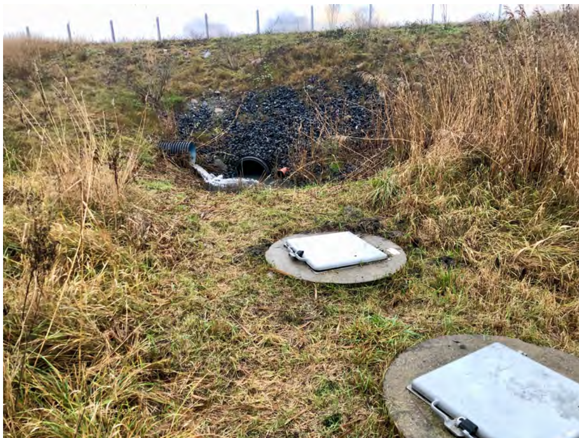
Ytterligare vattentrumma under väg 76.
