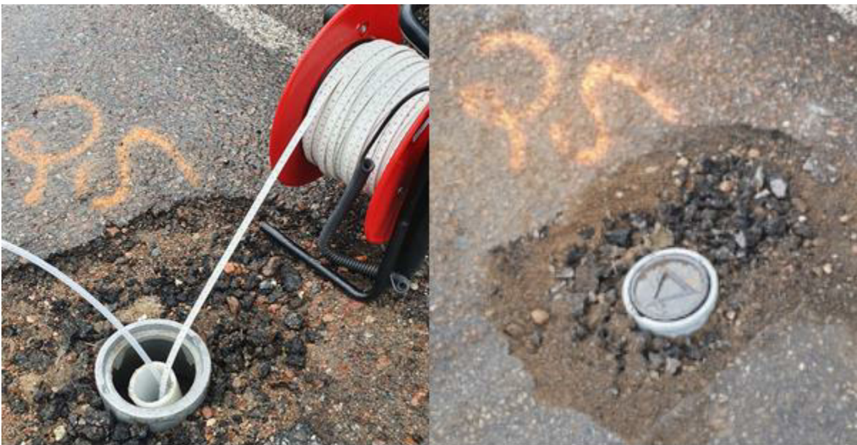
Bild 3. Foto från provtagning vid provpunkt 20WGV25 där ett grundvattenrör installerades, grundvattenprover uttogs med hjälp av peristaltisk pump. Fotot visar även att röret är skyddat med en däckel med lock.
