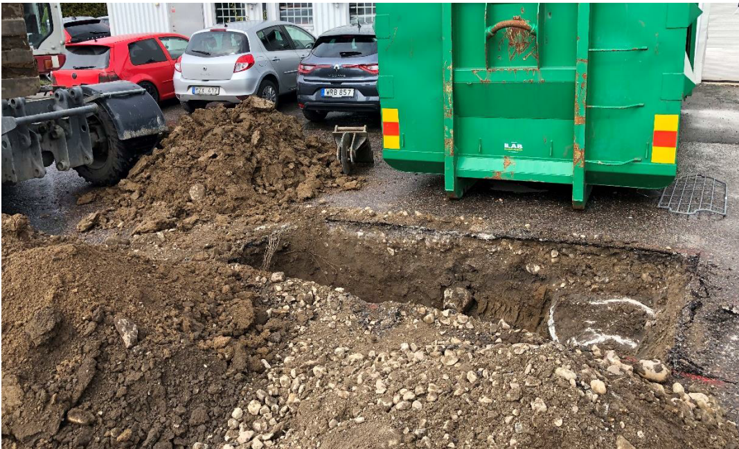
Bild 1. Foto från 20W17 där det syns tydligt olika högar på asfalten från olika nivåer, vilka sedan återfylldes i provgrop i samma ordning som jordmassorna grävdes upp.
