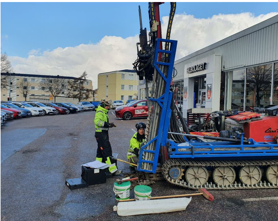
Bild 2. Pågående arbete vid provpunkt 20W25 där ett grundvattenrör installerades.
