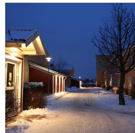
LJUSSATTA FASADER OCH ENTRÉER
