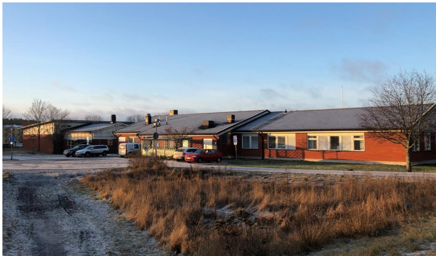
Vy från öster över befintliga skolbyggnader med idrottshallen längst till vänster.
