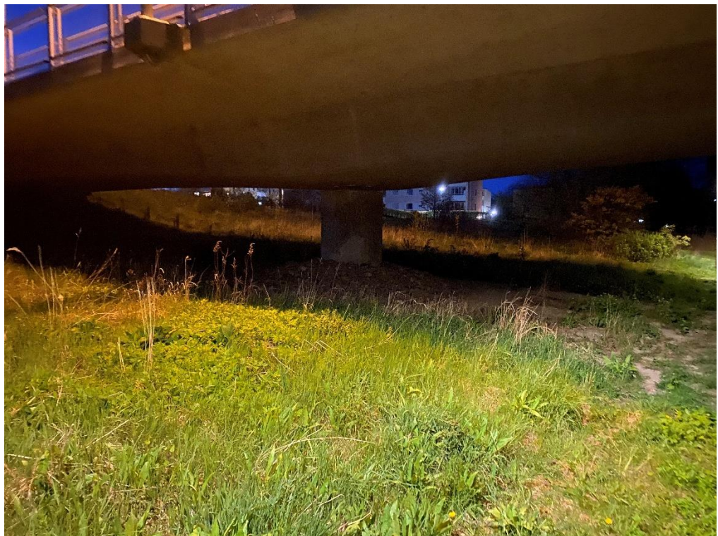
Passage under västra vägen i södra delen av inventeringsområdet, fotad 2020-05-20, vy från väst mot öst
