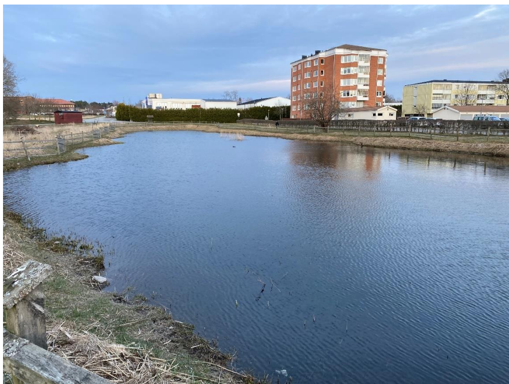
Damm 2 fotad 2020-04-08, vy från öst mot väst
