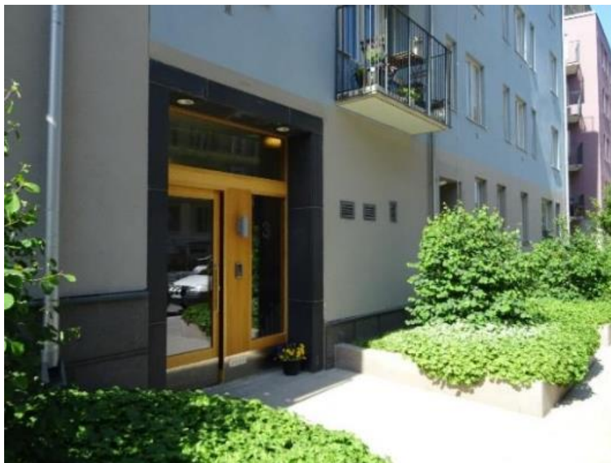
Figur 25. Exempel på regnbäddar för takvatten typ förgårdsmark, Stockholm. (Nacka kommun, 2018).
