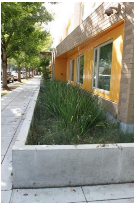
Figur 17. Bildexempel på en regnbädd (nedsänkt växtbädd) längs en husvägg. Bild: WRS.
