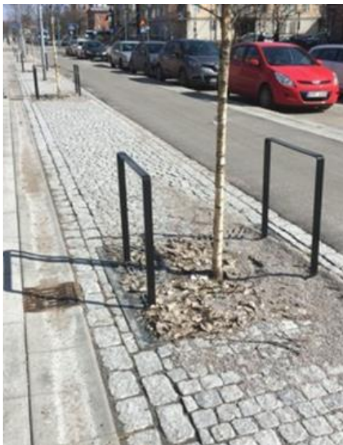
Figur 27. Exempel gatuutformning och träd i skelettjord på Strandbodgatan i Uppsala. Foto WRS AB.
