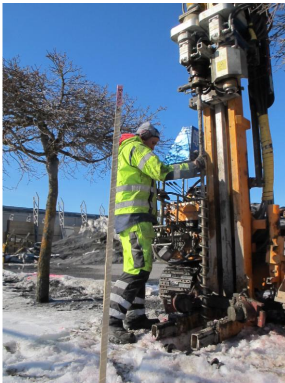
Bild 5: Provtagning vid BMZ41 där även ett markvattenrör installerats.
