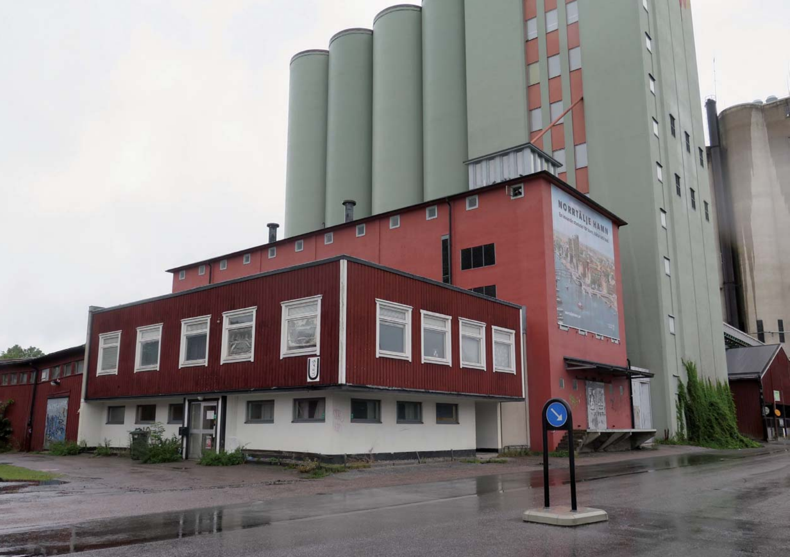
Fig. 18. Byggnad 5. U-huset sett från sydväst. LP_2014_00161.
