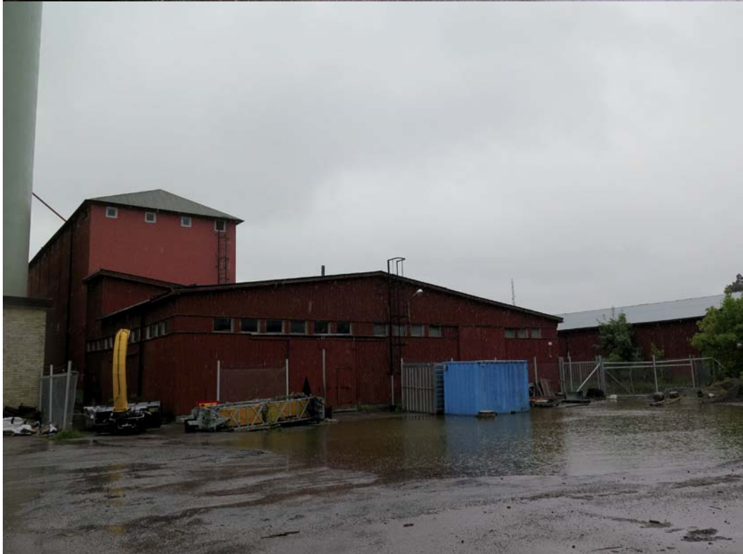
Fig. 19. Övre bilden. Byggnad 6. Byggnadens västra fasad. LP_2014_00162.
