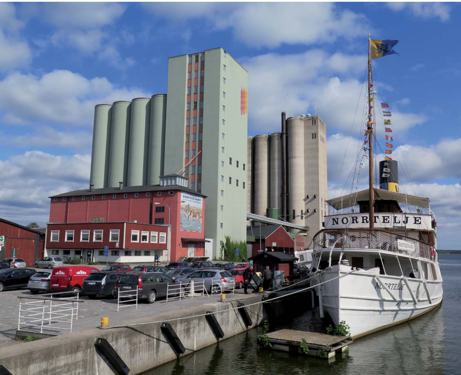
Fig. 1. Norrtälje hamns karaktäristiska silor och ångfartyget S/S Norrtelje. LP_2014_00147.
