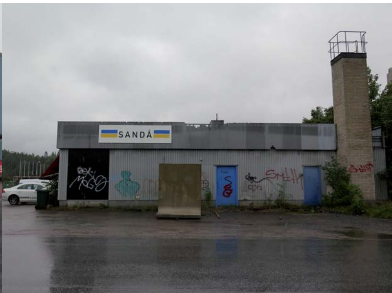
Fig. 37. Byggnad 18. Verksamhetslokal. Fasaderna med korrugerad plåt och funktionen som kontor och verkstad är typisk för området. LP_2014_00180.
