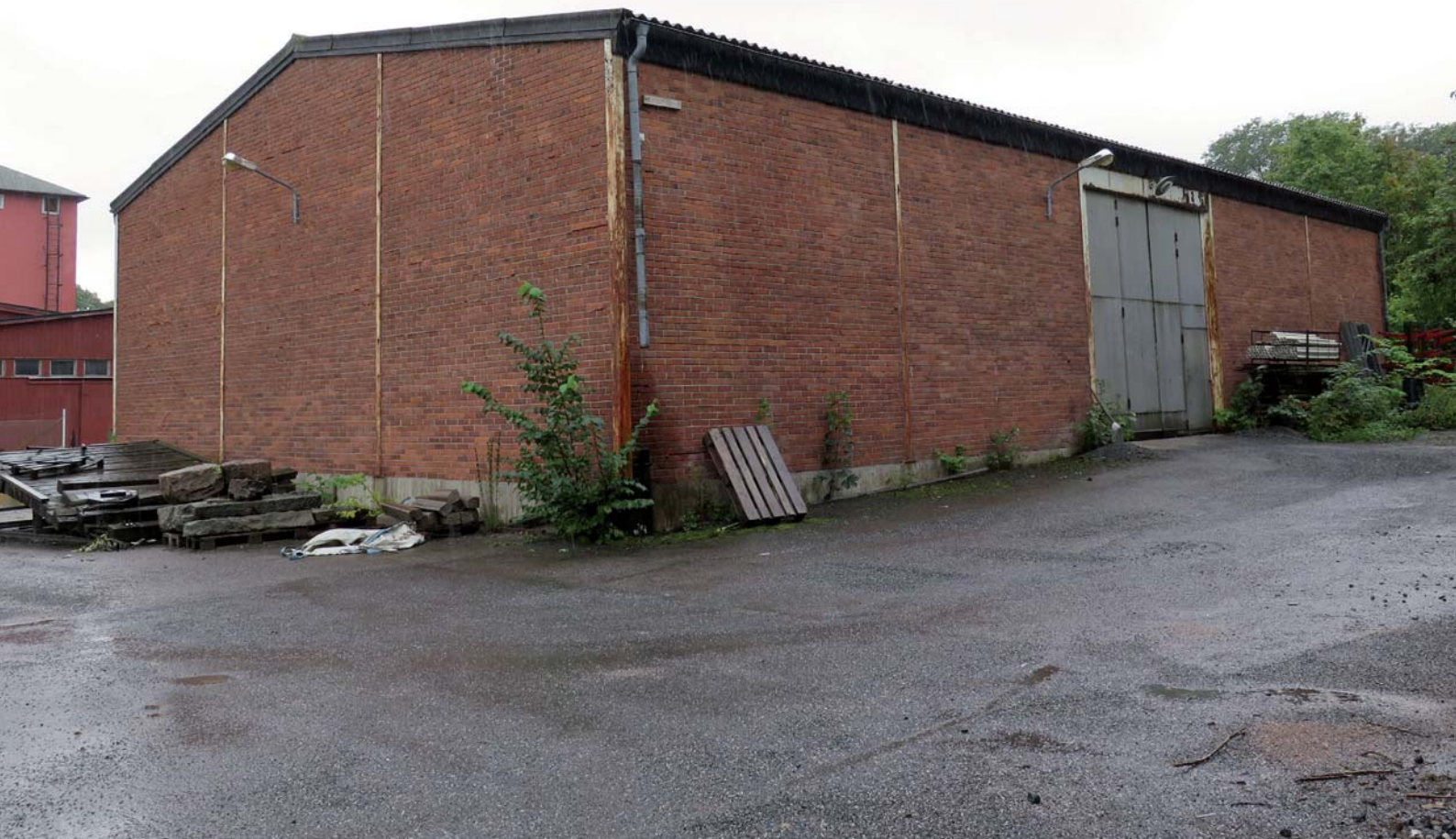
Fig. 25. Byggnad 10. Lagerbyggnaden fotograferad från nordost. LP_2014_00168.
