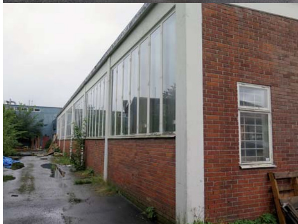
Fig. 28. Byggnad 11. Verkstadens fasad åt norr. LP_2014_00171
