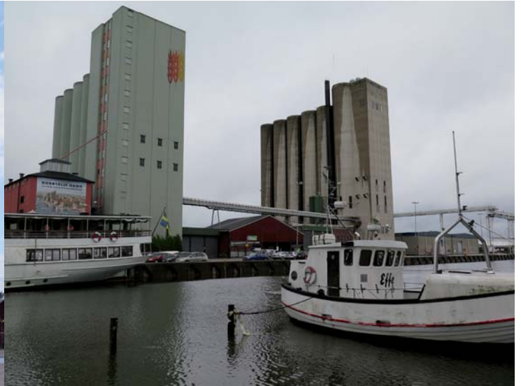
Fig. 11. Mellersta och östra silon. Fotografi taget från Societetsparkens strandpromenad. LP_2014_00153.
