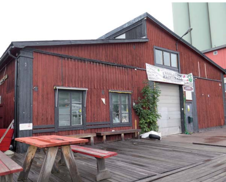
Fig. 21. Byggnad 7. Hamnladans södra fasad. Nuvarande takformen tillkom under en ombyggnad vid 1900-talets mitt. LP_2014_00164.
