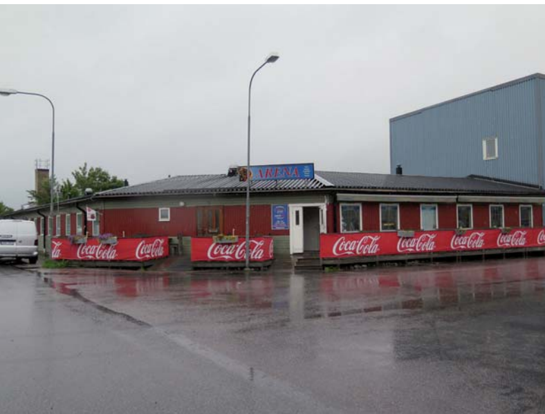
Fig. 36. Byggnad 17, pizzeria i korsningen Brännäsgatan-Pilgatan. LP_2014_00179.
