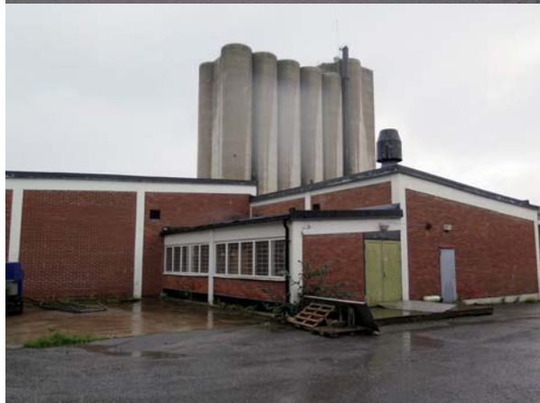
Fig. 27. Byggnad 11. Byggnadens äldsta del, fotograferad från nordväst. I bakgrunden syns den östra silon. LP_2014_00170.
