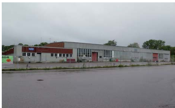
Fig. 26. Byggnad 11. Byggnadens fasad längs med Brännäsgatan. LP_2014_00169.
