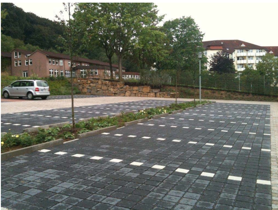
Figur 4. Exempel på utformning av växtbädd i anslutning till en parkering
