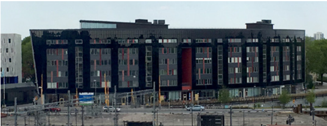
Den svarta fasaden är integrerade solceller
