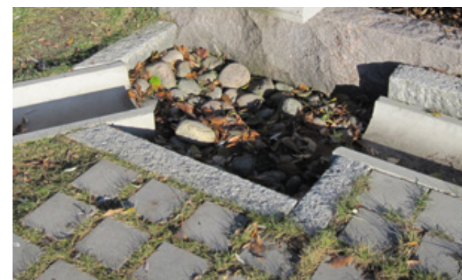
Vattentrappa, överst. Tråg och dagvattenrännor
