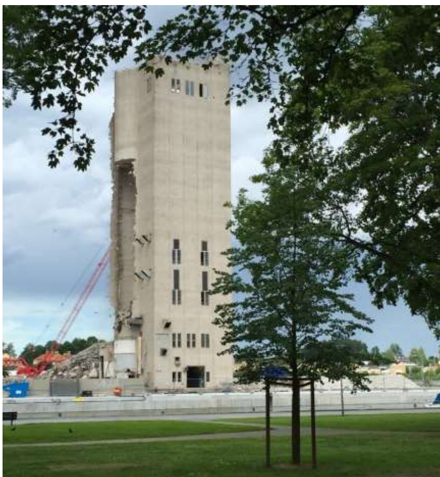
Figur 7 Vy från Societetsparken under rivningen av silon.
