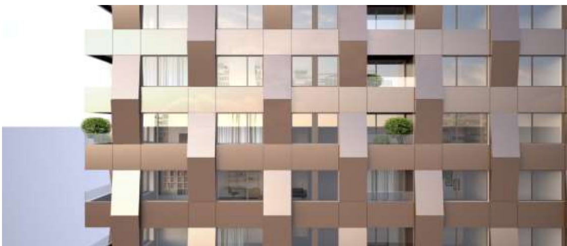
Figur 11 Förslag på gestaltning av metallfasad med veckning (Sandellsandberg arkitekter)
