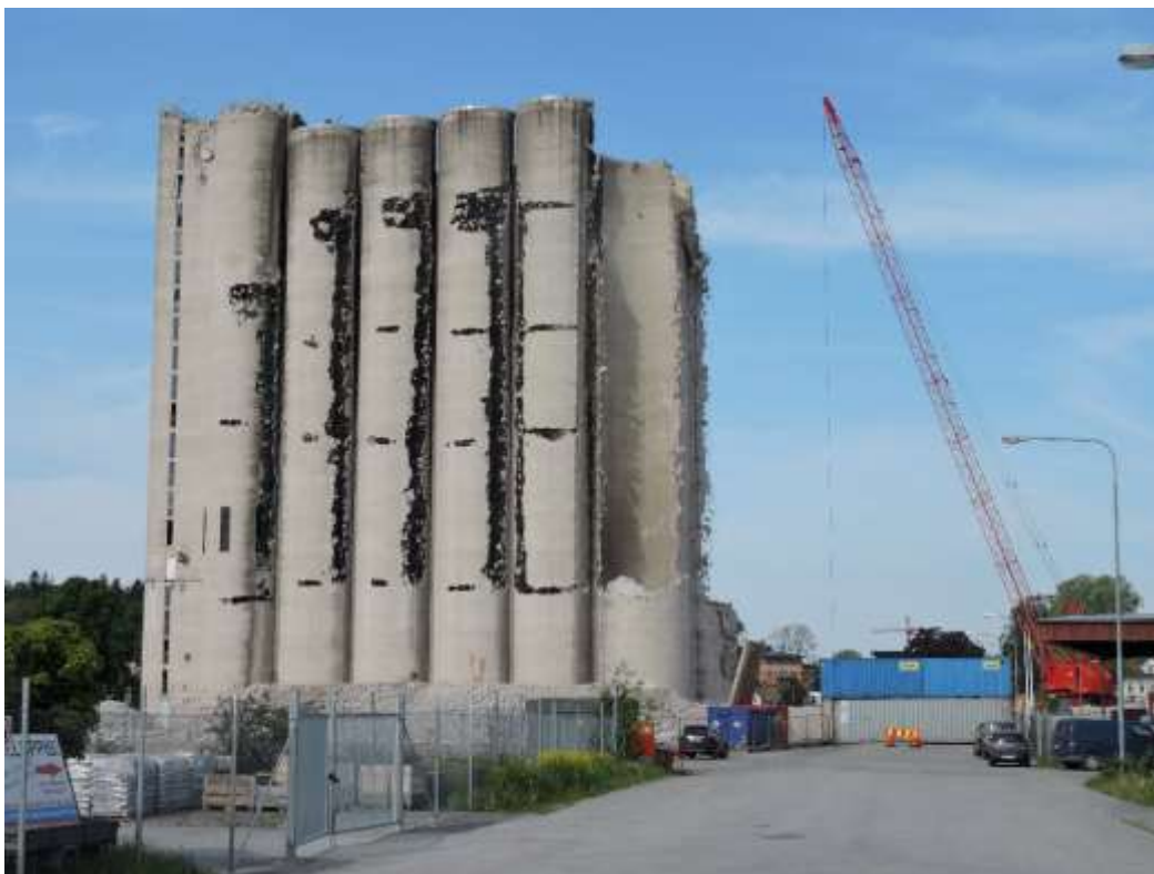
Figur 6 Platsbild vid rivningen av silon. Ytorna kring silon nyttjades för industriverksamhet och var helt hårdgjorda.
