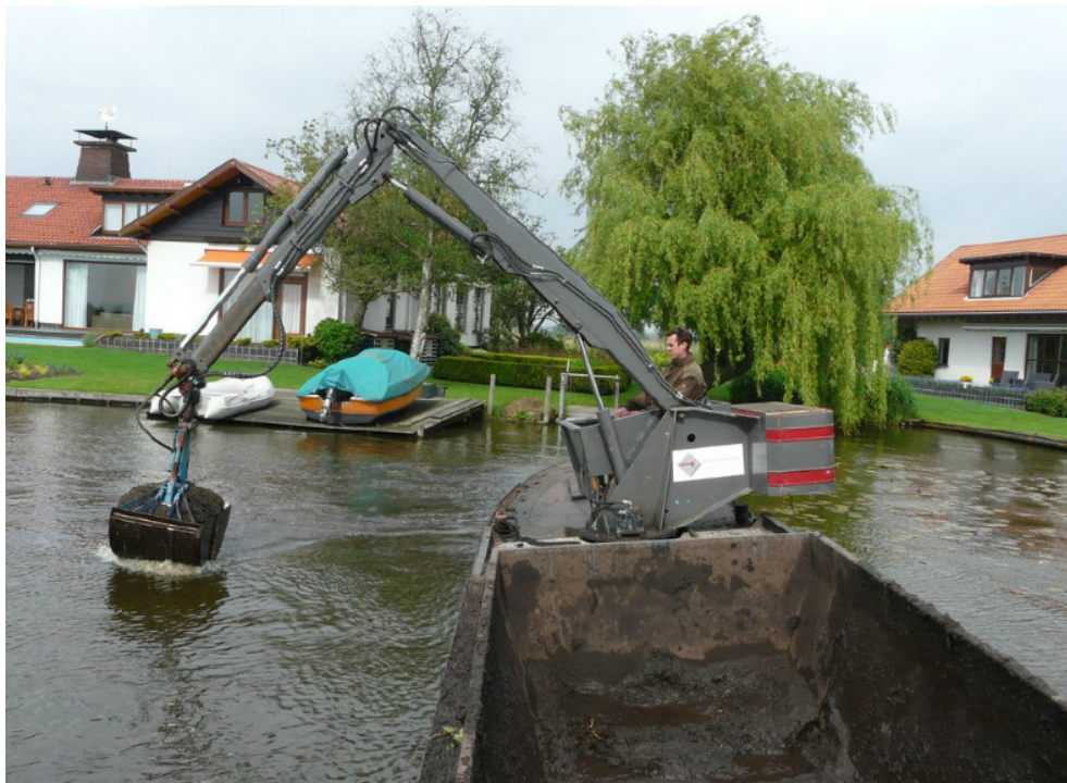
Figur 8. Exempel på grävuddring med en potongrävare. Potongrävaren är monterad på en pråm med lastrum för muddringsmassor (Andersson et al, Skötsel av dagvattendammar – en handbok, 2013).
