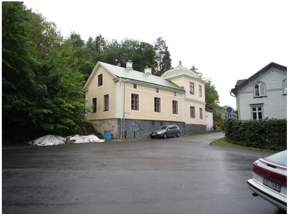
Vy mot Klippan 9 och 8 mot Skepparegatan
