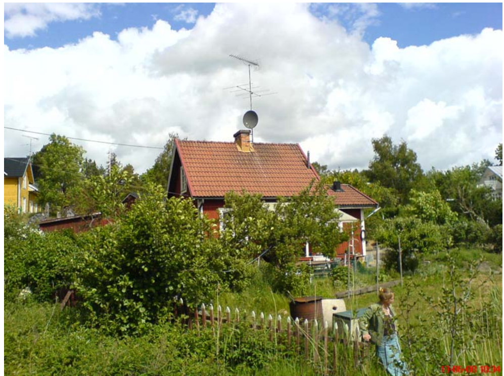
Harg 47:1, bostadshuset från söder
