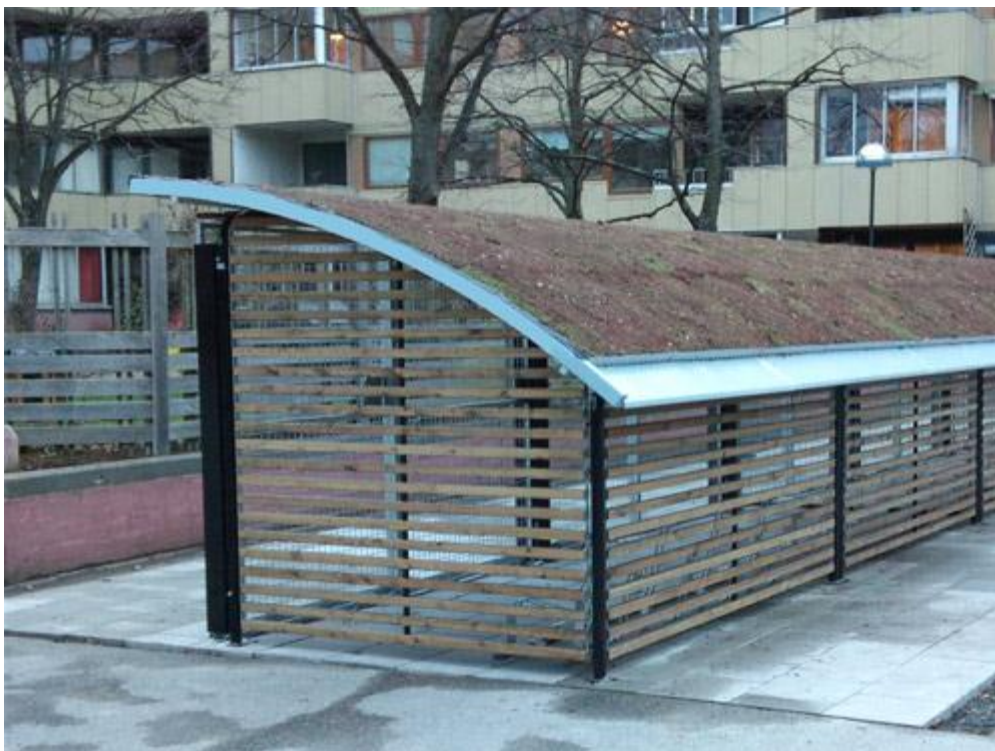
Figur 7: Exempel på hur en anläggning av gröna tak på bibyggnader kan se ut
