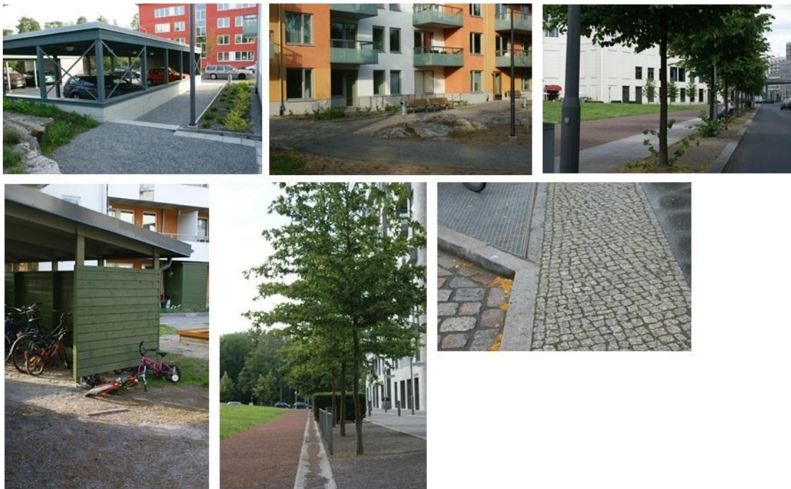
Figur 6: I bilden visas exempel på markbeläggningar som ökar genomsläppligheten och som kan användas för gång- och cykelstråk
