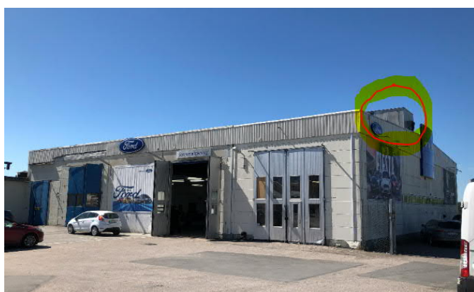
Figur 9 Placering på fläktaggregat ovanpå huset.
