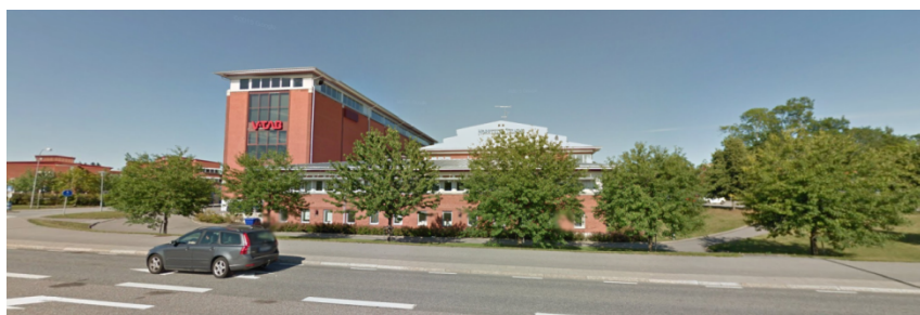
Figur 2. Foto över befintliga byggnader. Taget från Estunavägen (Google maps)
