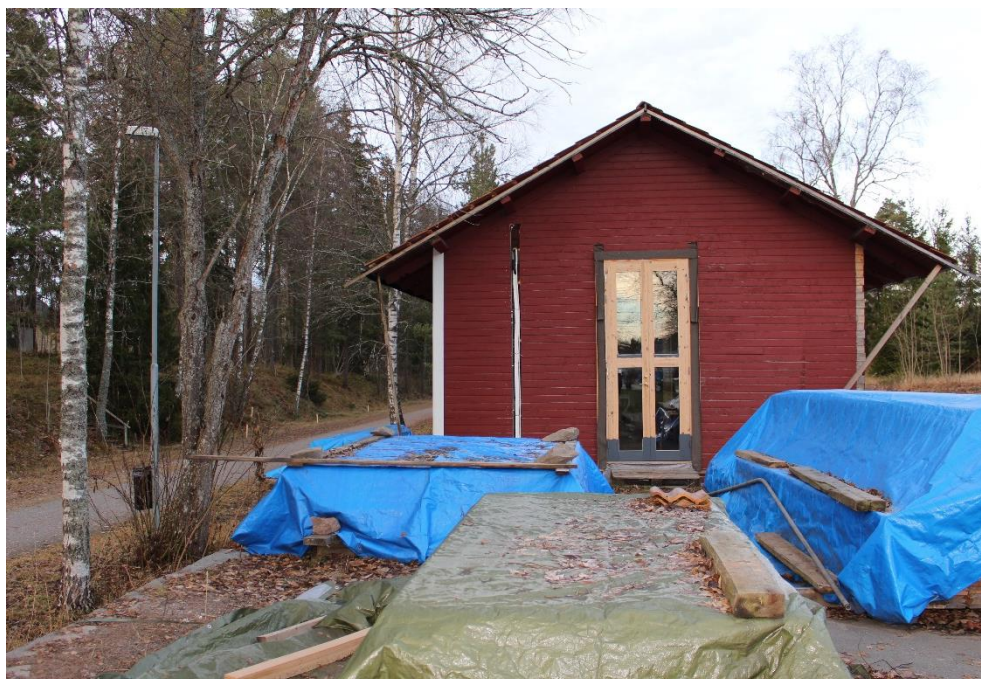
Godsmagasinet och cykelvägen, sett från söder. Bilden är tagen då renovering av byggnaden pågick, i enlighet med beviljat bygglov.
