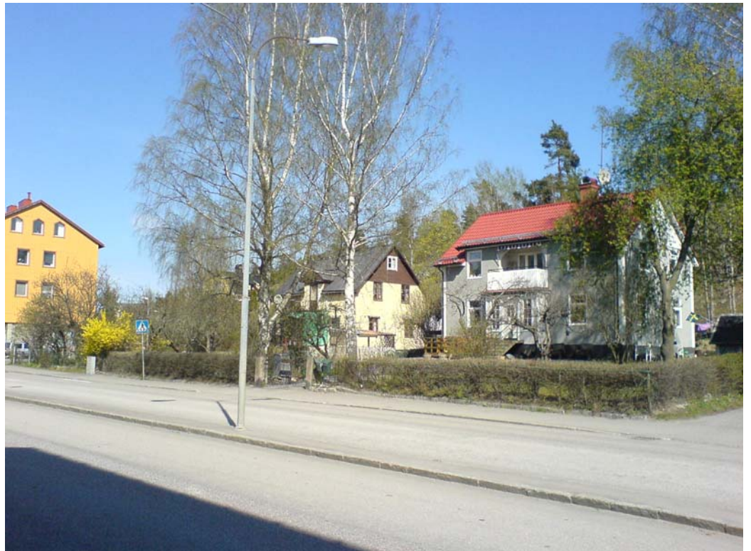
Gavel på Råkan 1, Göken 5 i mitten med befintlig byggnad som avses rivas och Göken 4 till höger. Bild från Roslagsgatan.
