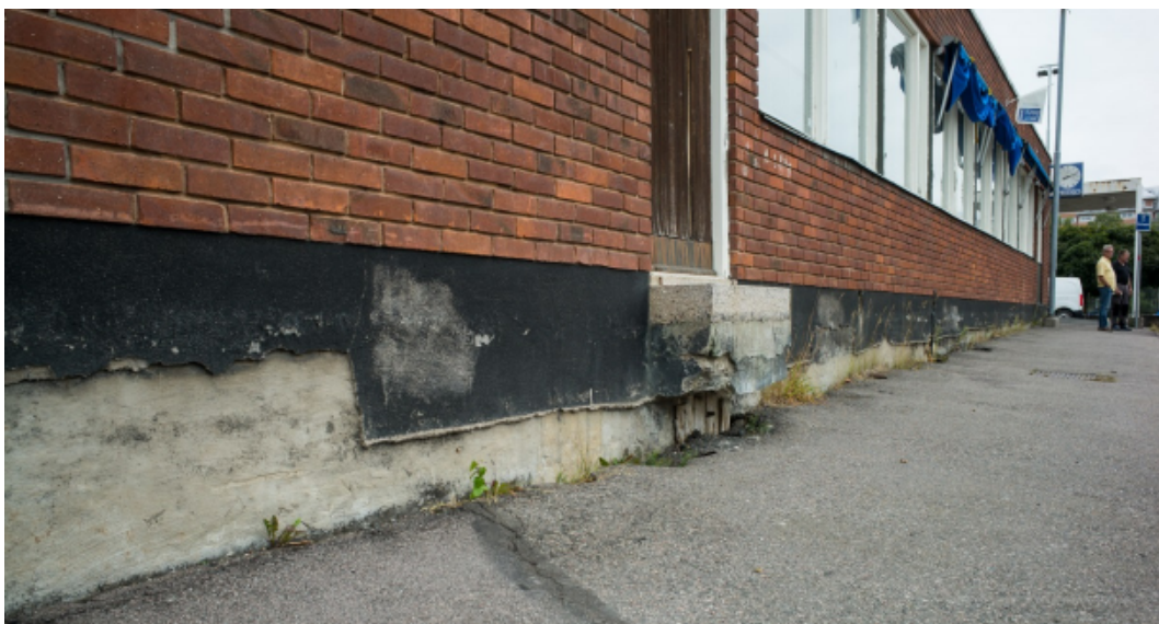
Figur 2 Sättningsdifferenser mellan pålad byggnad och omgivande oförstärkt terräng, exempelvis asfalterade ytor
