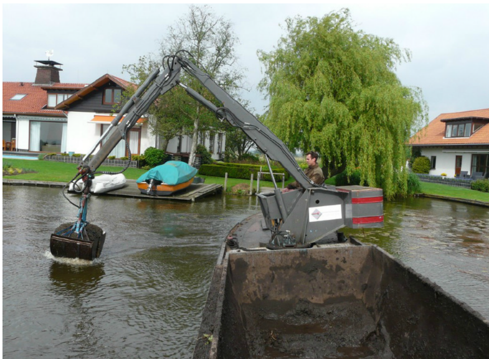
Figur 7. Exempel på en grävmaskin med lång räckvidd som tömmer en damm på sediment. Första bilden från Andersson et al, Skötsel av dagvattendammar – en handbok, 2013. Andra bilden från Trafikverket, Publikation 2015:147 – Öppna vägdagvattenanläggningar.
