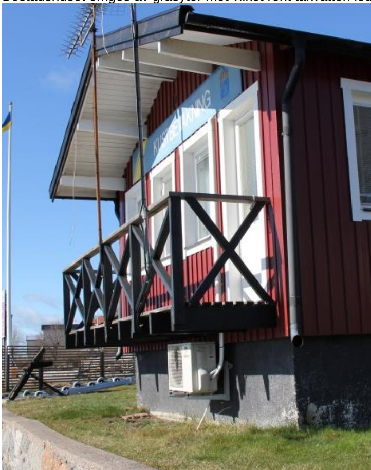
Dagvatten leds ut i stuprännor mot gräsytor.
