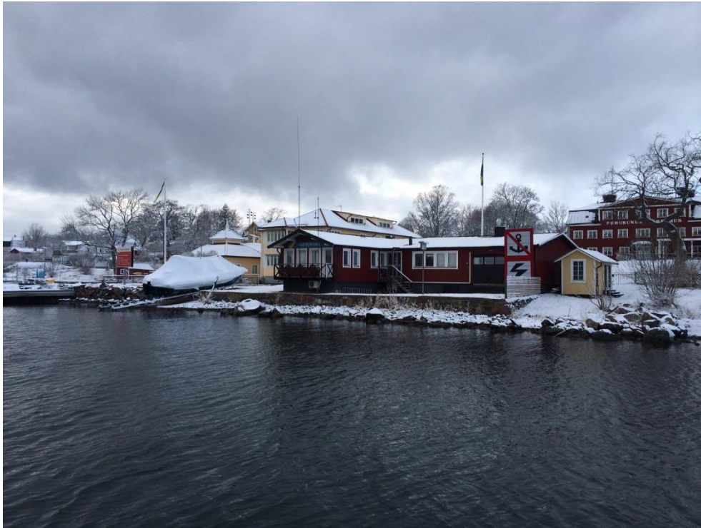
I början på 1970 talet fick byggnaden sin nuvarande utformning.
