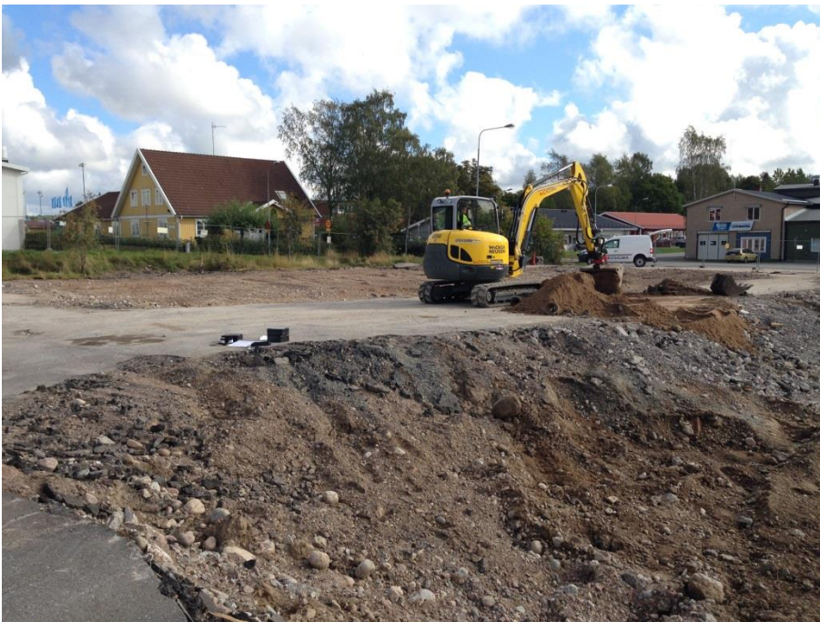
Figur 9. Schaktning av.GPG1410. Provgrop GPG1408 i förgrunden.
