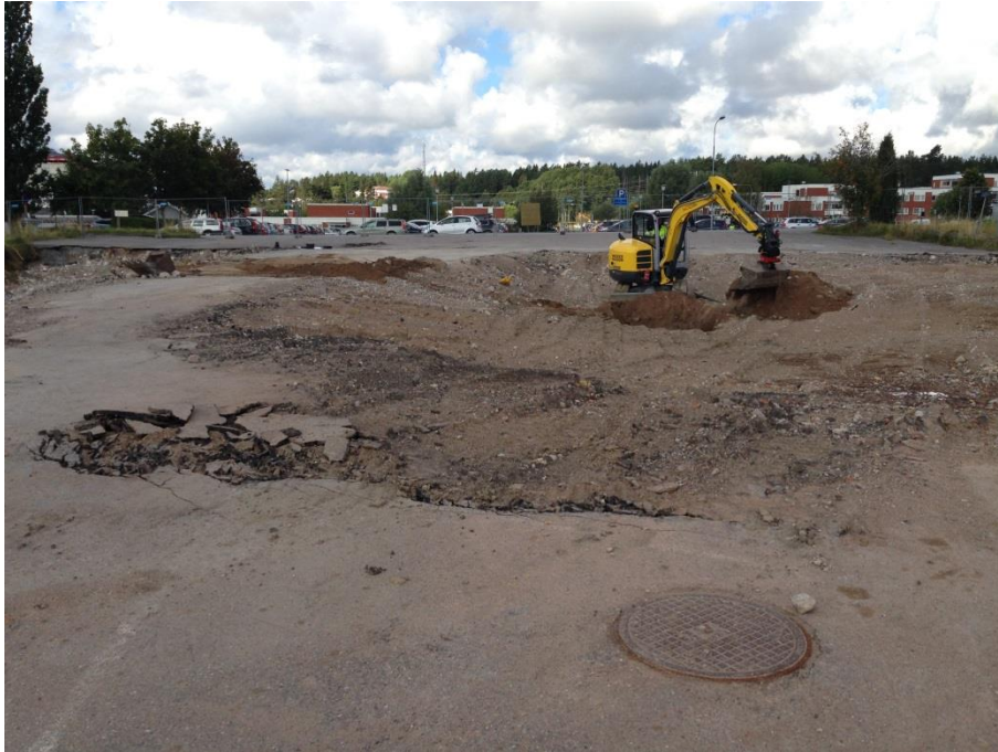
Figur 10. Schaktning av GPG1411 med provgrop GPG1410 till vänster i bild.
