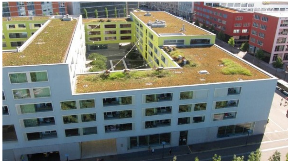
Figur 9. Exempel på byggnader med gröna tak. Zürich.
