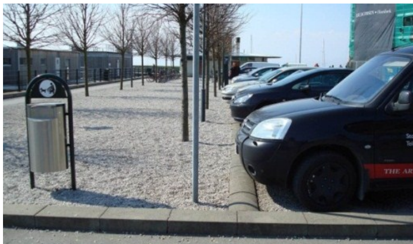
Figur 11. Exempel på val av material för att minska avrinningen.
