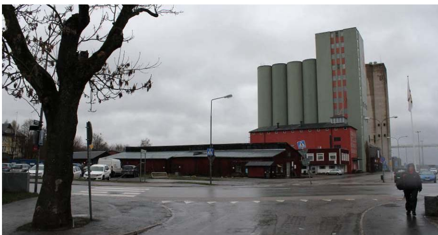
Planområdet sett från väster. Roslagsgatan närmast och silos i bakgrunden.
