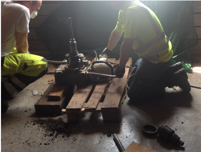
Bild 3: Skruvborrprovtagning med handburen jordborr i BP5.
