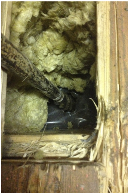
Bild 5A: BP4 Provtagning under befintligt golv.
