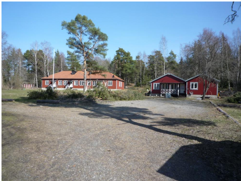
F d barnkolonins huvudbyggnad. Tas i anspråk som vandrarhem och för konferenser. Byggnaden till höger blir restaurang/frukostkök.
