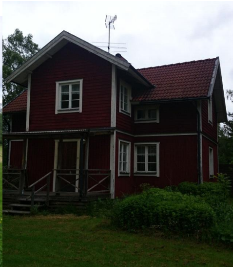
Befintlig äldre byggnad
