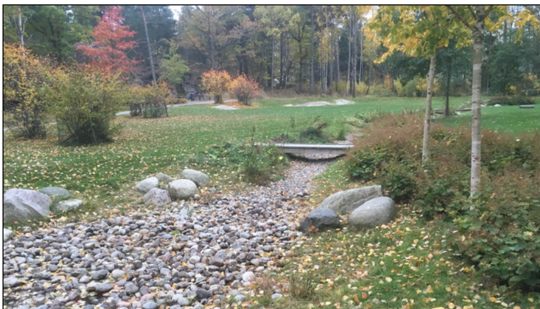
Figur 13. Exempel på hur ett krossdike kan se ut. Foto: Geoveta.
