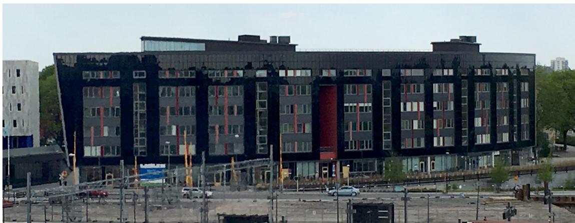
Den svarta fasaden är integrerade solceller
