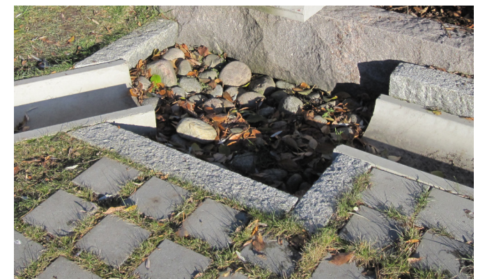
Vattentrappa, överst. Tråg och dagvattenrännor
