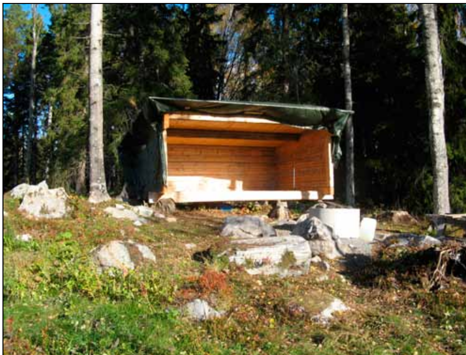
Figur 4. Nybyggt vindskydd på stora åkerholmen. Foto Maria Ericsson.
