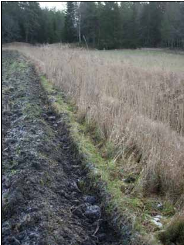
Figur 10. Kantzon saknas. Bilden visar ett vattendrag där kantzon helt saknas. Växtligheten i vattendraget är riklig och näringsläckaget är sannolikt högt.
