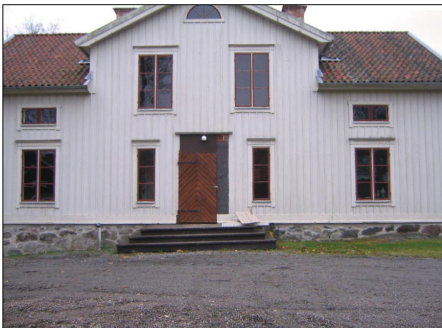
Mangårdsbyggnaden på Färsna är uppförd 1887 i timmer och omfattar 1 ½-plan om ca 270 m 2 . Byggnaden har totalrenoverats utvändigt och renovering pågår invändigt. Den är lämplig att bedriva naturskola i. Foto Carina Brage.
