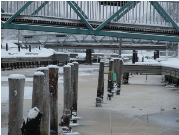
56) Åkers kanal i Åkersberga centrum
