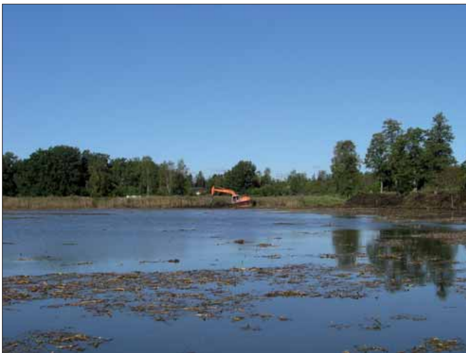
Sjön Ludden strax utanför Norrtälje stad restaurerades under år 2006 genom att vassrotfilt grävdes bort. Restaureringen gjordes inom ramen för lokala investeringsprogrammet (LIP2). Foto Monica Pettersson.
