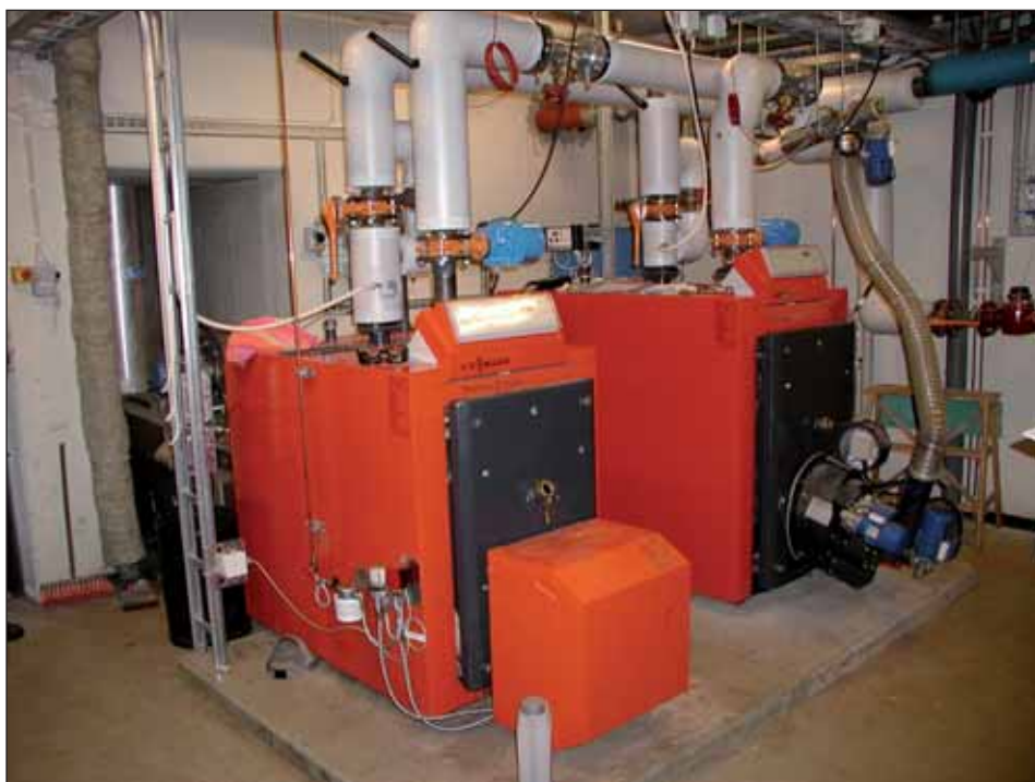
I Skederids skola byttes de gamla oljepannorna ut mot pelletspannor under år 2000 inom ramen för Lokala investeringsprogrammet (LIP1). Genom insatsen har utsläppet av koldioxid minskat med ca 100 ton per år. Foto Magnus Bergström.
