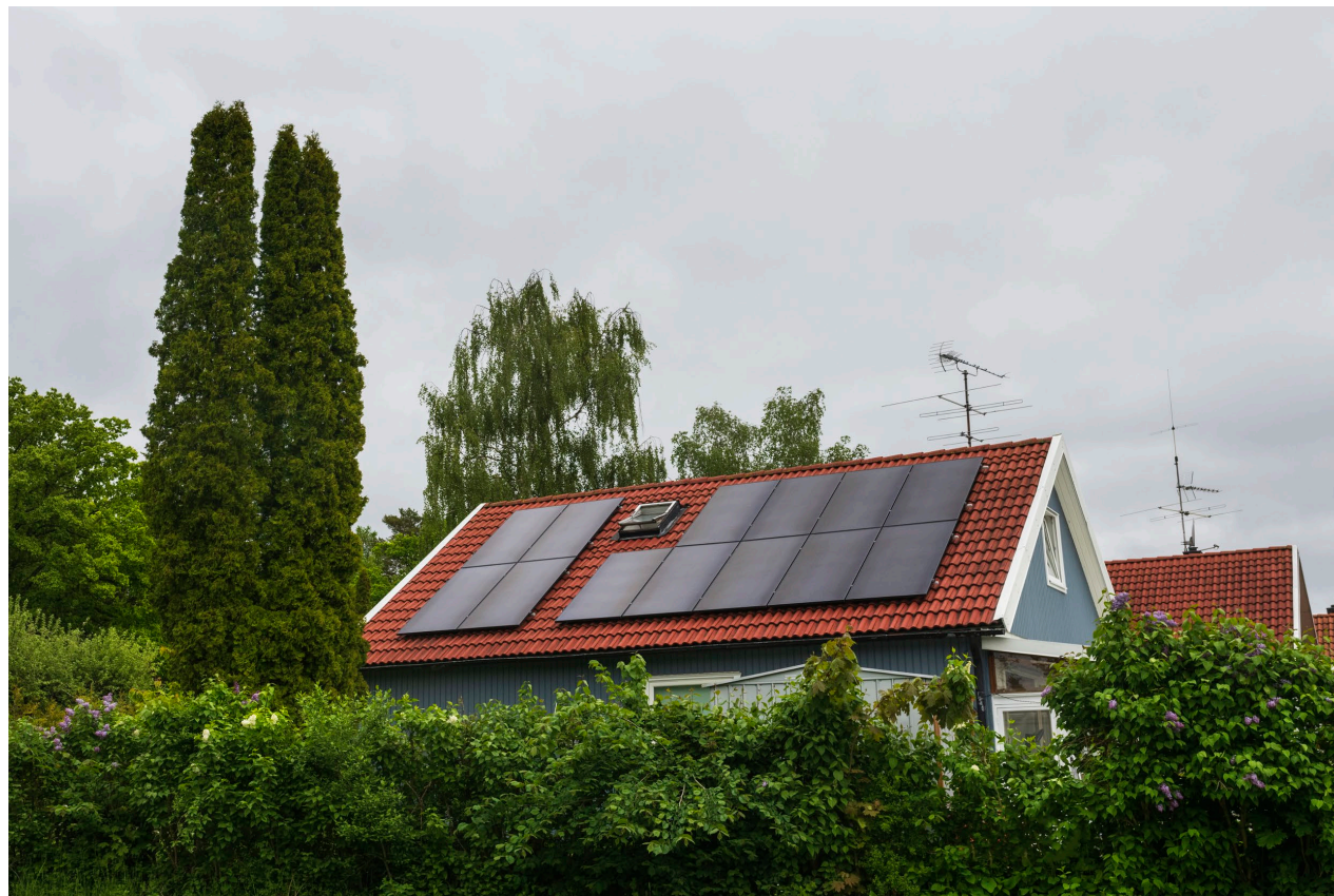
Solceller på villatak
