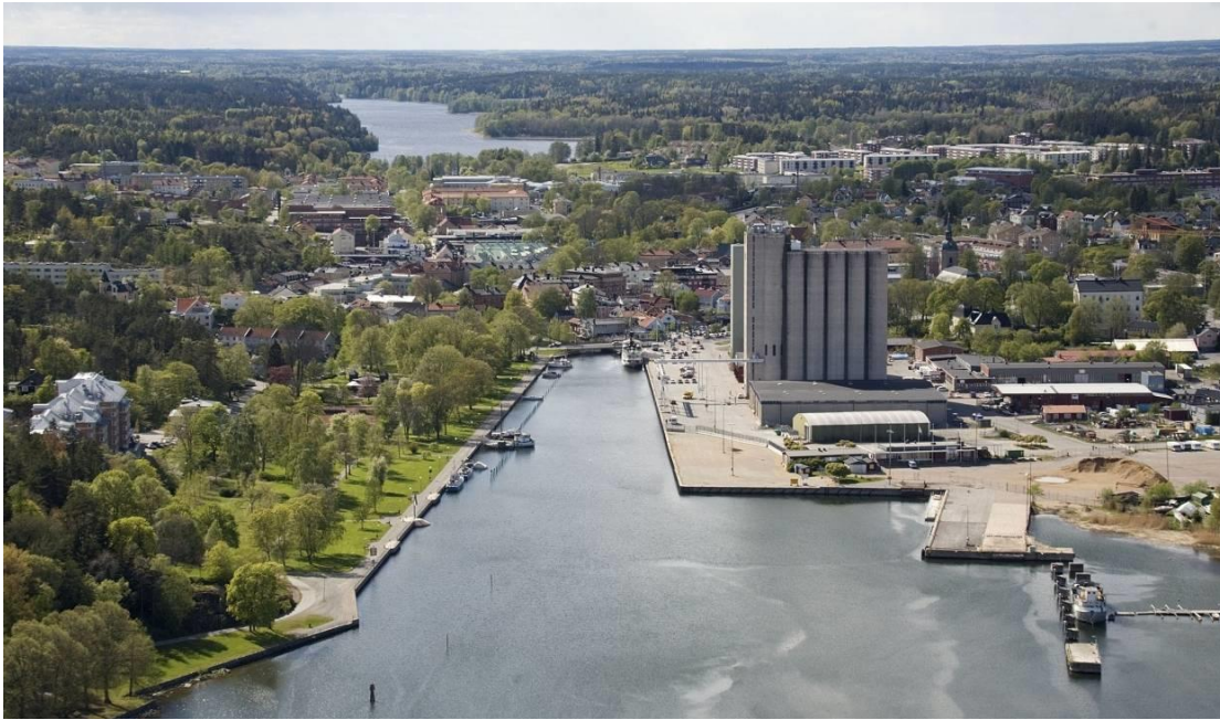
Norrtälje Hamn innan påbörjade byggarbeten (utsikt mot hamnen från öster).
